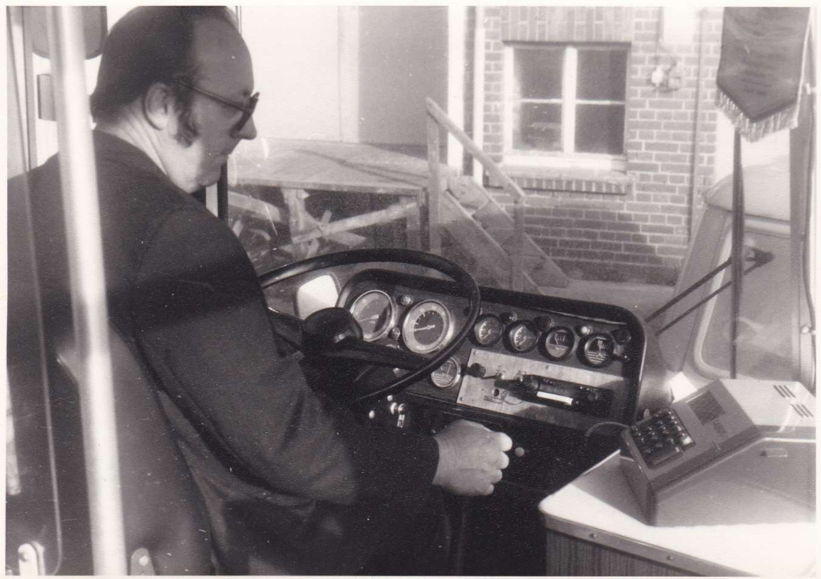
Bild 17: Der mobile Fahrscheindrucker FABUS 1 im Praxiseinsatz, Verkehrskombinat Gera, ca. 1987/1988
